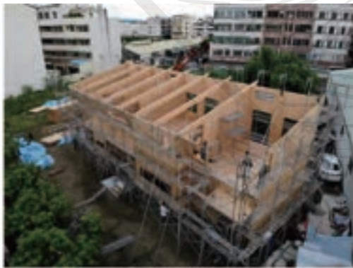
CLT木構住宅
