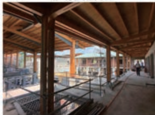
化石館木構工程
