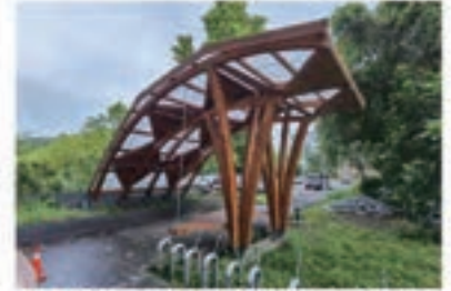
臺灣大學土木研究大樓停車場側戶外棚架 建築設計：臺灣大學土木工程學系師生 完工：2022年5月
