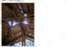
即瑪夏民權國小圖書館 Library of Tsunetsugu elementary school 結構：新川誠 建築設計：新川誠、新川誠 完工：2010年12月 榮獲：2012年台灣建築獎
